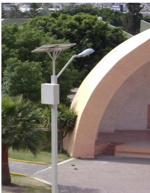
Ilustración 23: Luminaria solar autónoma de un panel solar fotovoltaico
