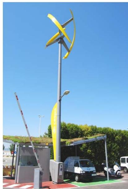
Ilustración 25: Aerogenerador vertical
